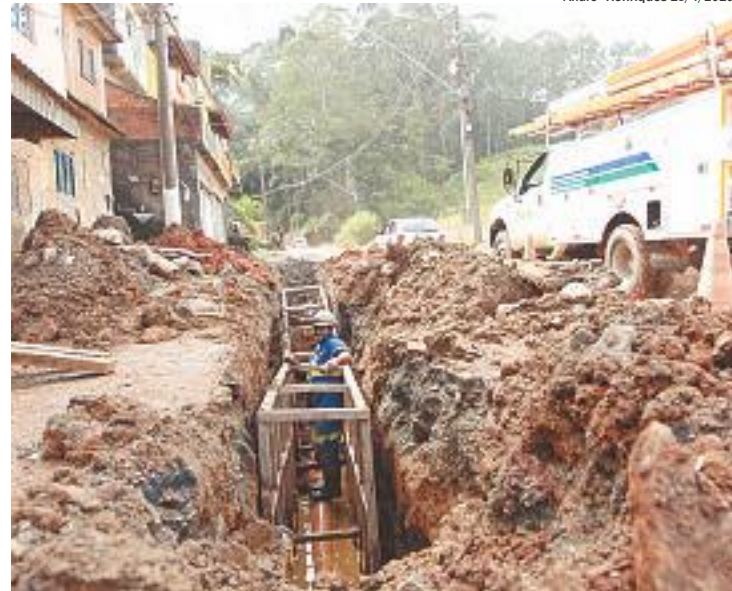
Procedimento convencional emite muito ruído e interdita vias
